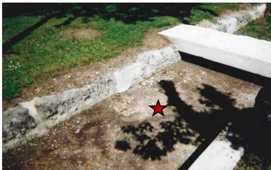
L'étoile rouge ci-dessus indique l'arrivée du drain de drainage dans un regard. Ensuite les eaux, par un autre tuyau, passent sous l'anneau dallé de circulation des trois chevaux pour couler sur le décaissement plus bas des deux voies Decauville.
