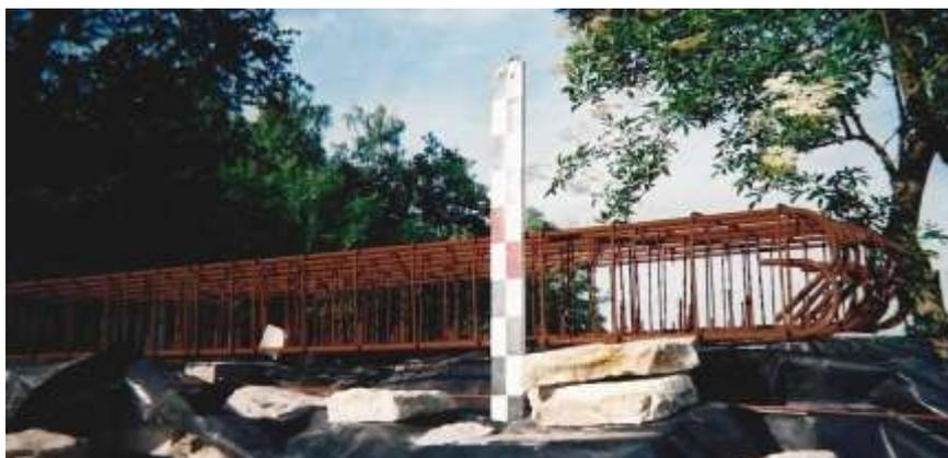
La photo du haut montre un ancien fer de renfort Daubin situé côté sud, dans la partie haute du muraillement du puits.
