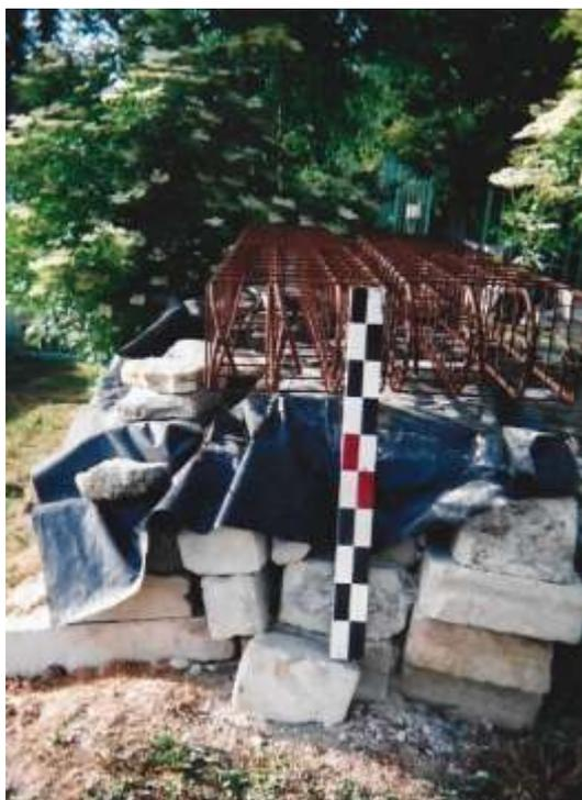
de même comme le montre les deux photos inférieures : **il s'agit des armatures pour les fondations en béton armé « spécial pile de pont ».**
